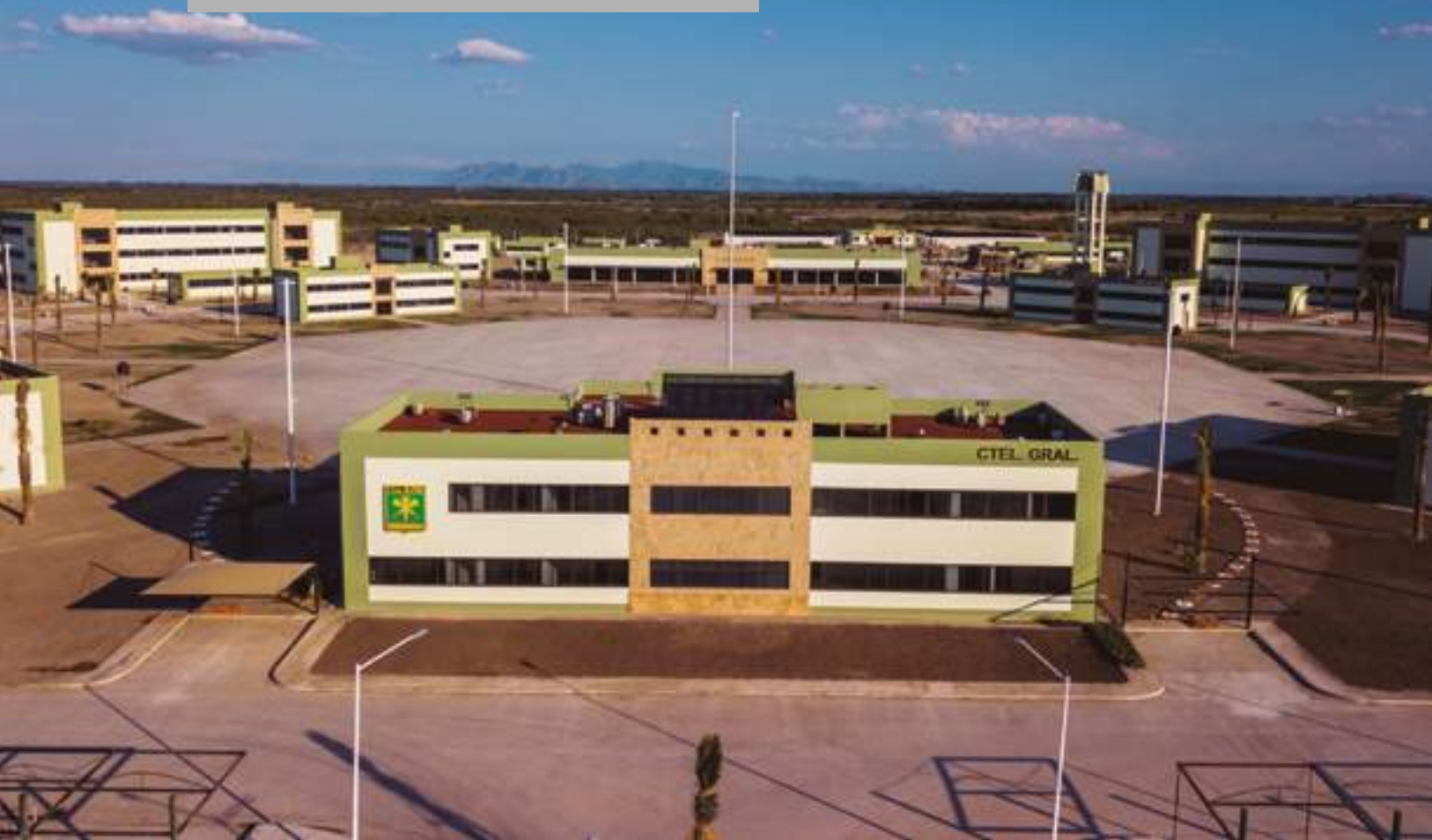
Construcción del Cuartel del 9.º Batallón de Policía Militar, en San Pedro.
