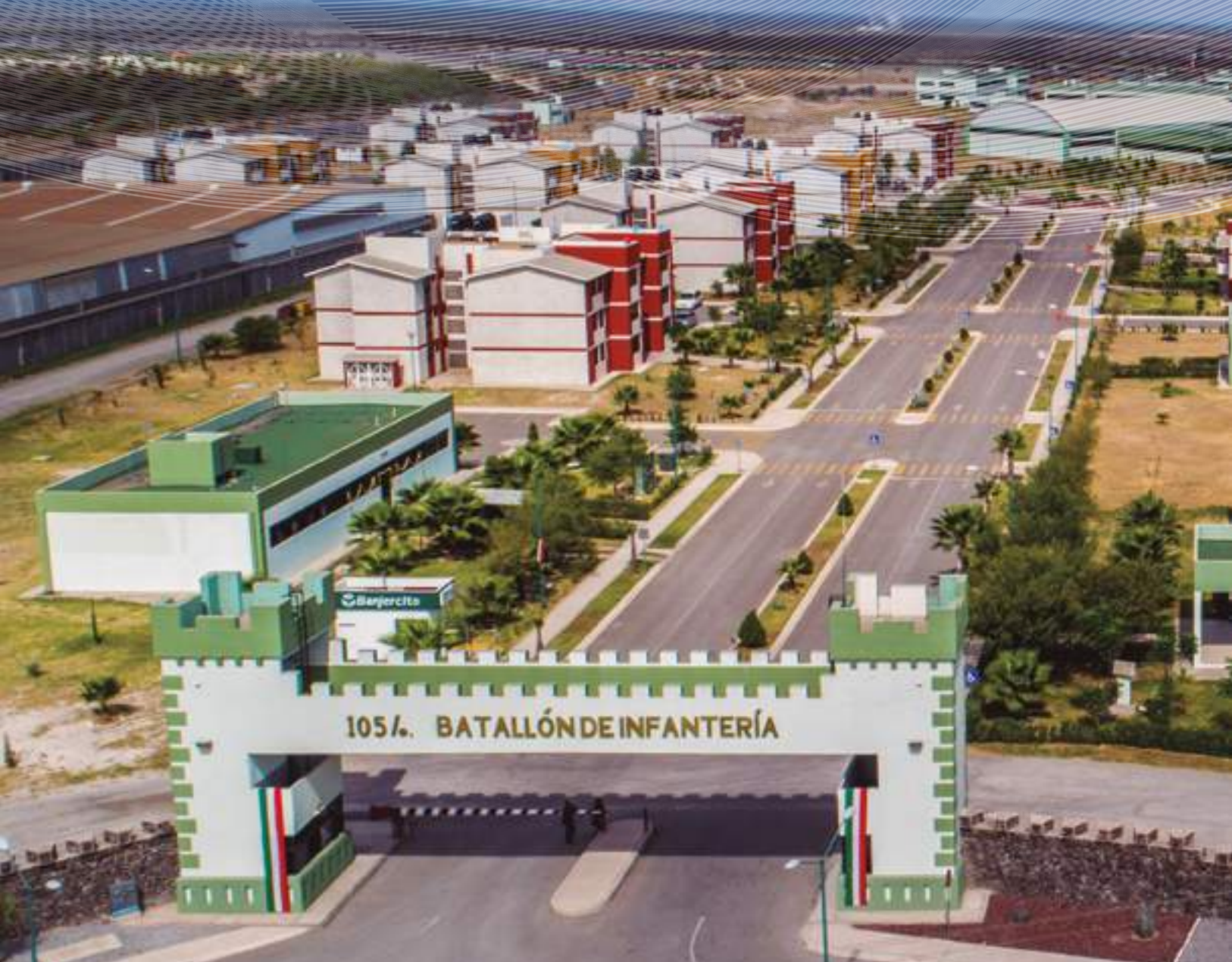
Construcción del cuartel del 105/o Batallón de Infantería, en Frontera.
